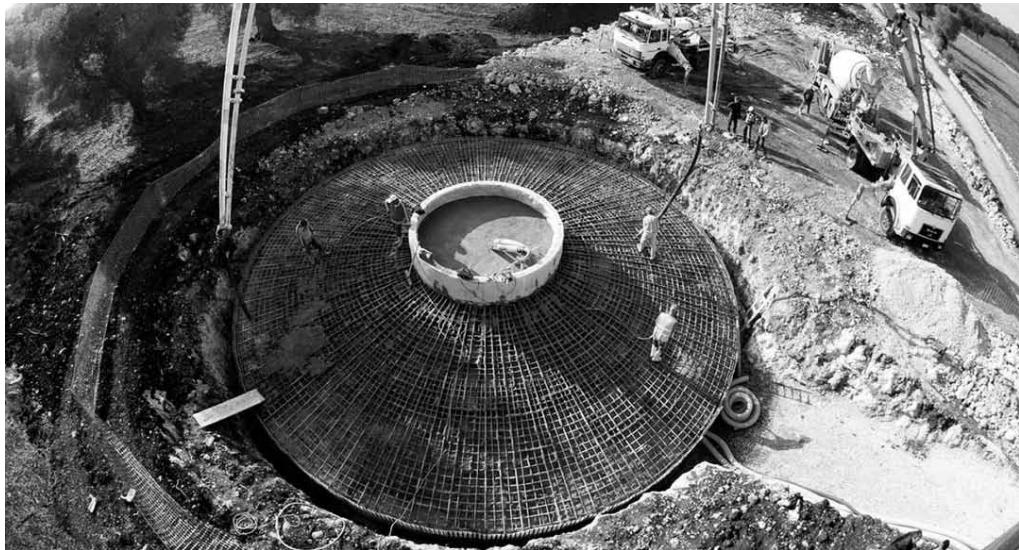
te di cemento necessarie per ciascun basamento delle pale (3000x7!), in buche dal diametro di 20 metri, profonde almeno 4, con una palificazione profonda più di 25. Tutto questo cemento chiaramente non può essere trasportato dalle betoniere sulla strada in costruzione, che nonostante tutte le devastazioni rimane troppo ripida. Quindi, la bella pensata è di costruire una zona di betonaggio nel cuore della foresta.
