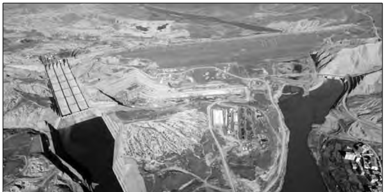
Due immagini dell'immensa diga di Ilisu sul Tigri, una delle ventidue previste nel Progetto GAP (Güneydoğu Anadolu Projesi - Progetto Anatolia del Sud).
