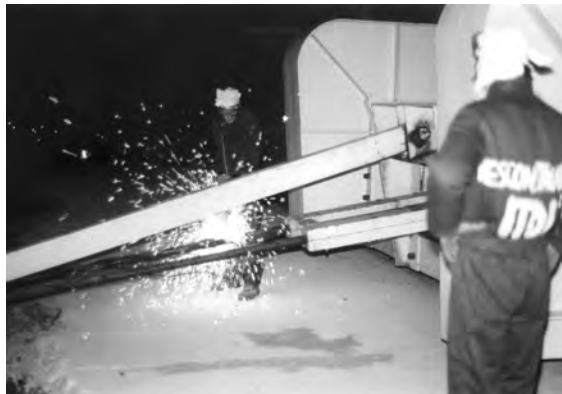
Aprile 1996: taglio dei cavi per il trasporto del cemento.
