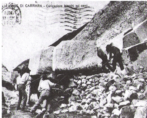
VALLE DI CARRARA - Caricamento blocchi sui carri
