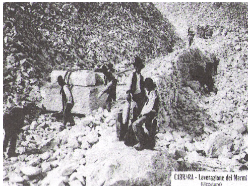
CARRARA - Lavorazione del Marmo (lizzatura)
